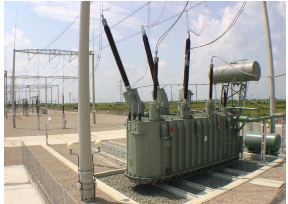
AT 400 MVA după retehnologizare
